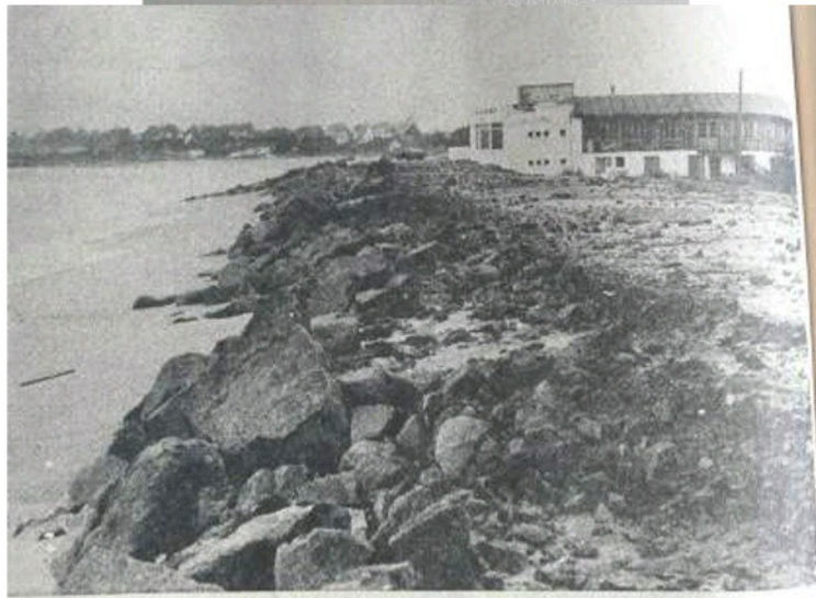
LORIENT-PLAGE. — La digue de protection aménagée par la municipalité à la hauteur de l'hôtel des Bains a été sérieusement malmenée. A l'heure de la pleine mer, vers 5 heures, les vagues sont passées sur l'ouvrage jonchant les terrains en contrebas et entraînant une masse de cailloux provenant des brèches.
